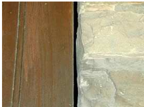
Mauvais raccord entre le mur et la menuiserie
