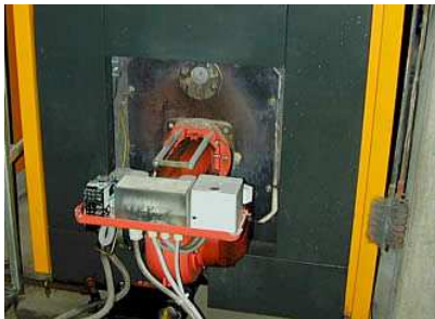
Chaudière de 1972 : la porte foyer peu isolée dont la température de surface durant le fonctionnement du brûleur est proche de 100°C.
