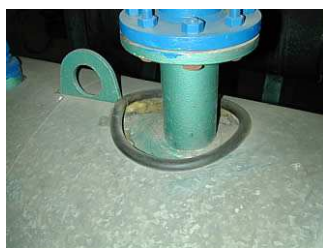
Chaudière de 1979 isolée par 3 cm de laine minérale et comportant certaines zones non isolées
